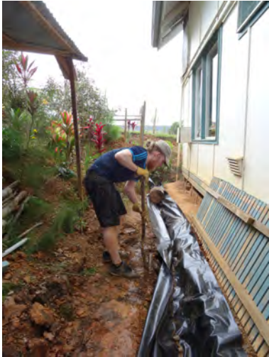
Mikko kaivaa uutta ojaa talon taakse
